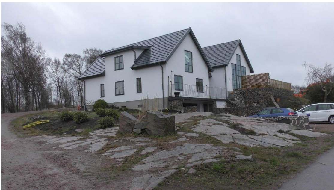
Byggnadens befintliga fasader mot nordost och nordväst, sett från B-vägen. Foto från syn i mark- och miljödomstolen 2017-04-24.
