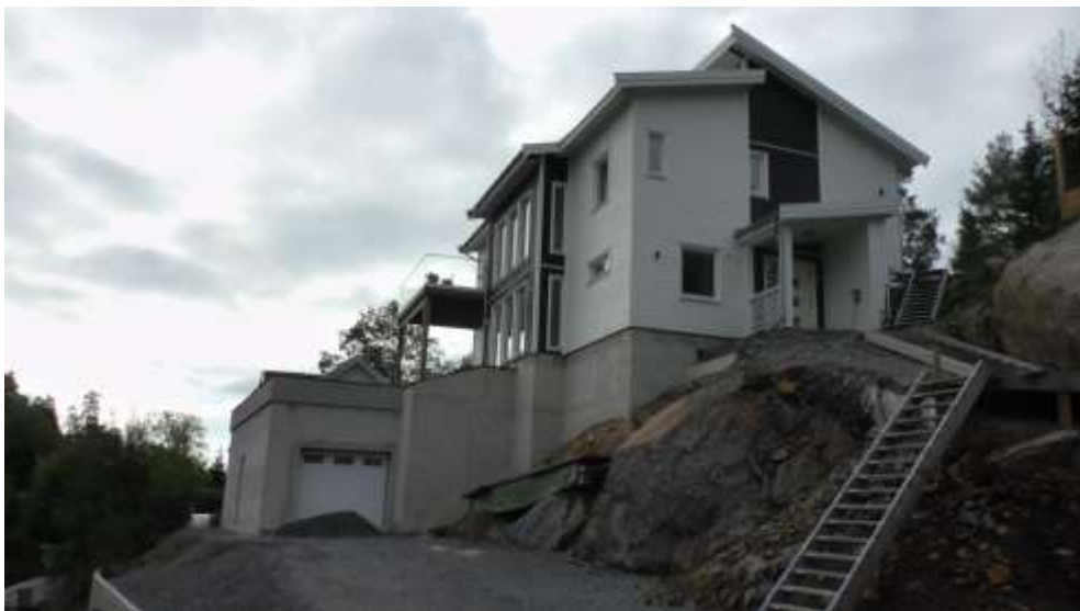
Fotografi från syn, byggnadens nordvästra fasad
