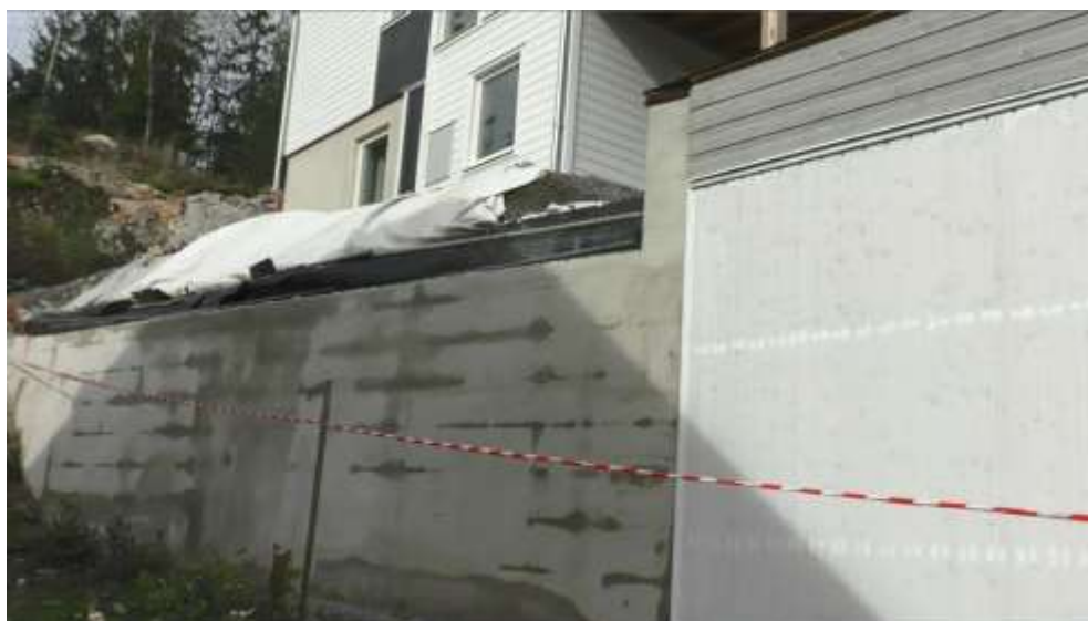
Urklipp från videoupptagning från syn, byggnadens sydöstra fasad
