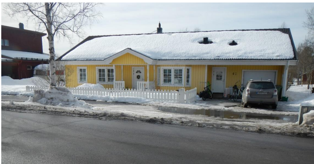
Figur 2. Bostadsbyggnaden på E, sett från Grubbevägen. I stort sett hela fastighetens utrymme för utevistelse är på baksidan av byggnaden, in mot kvarteret.
