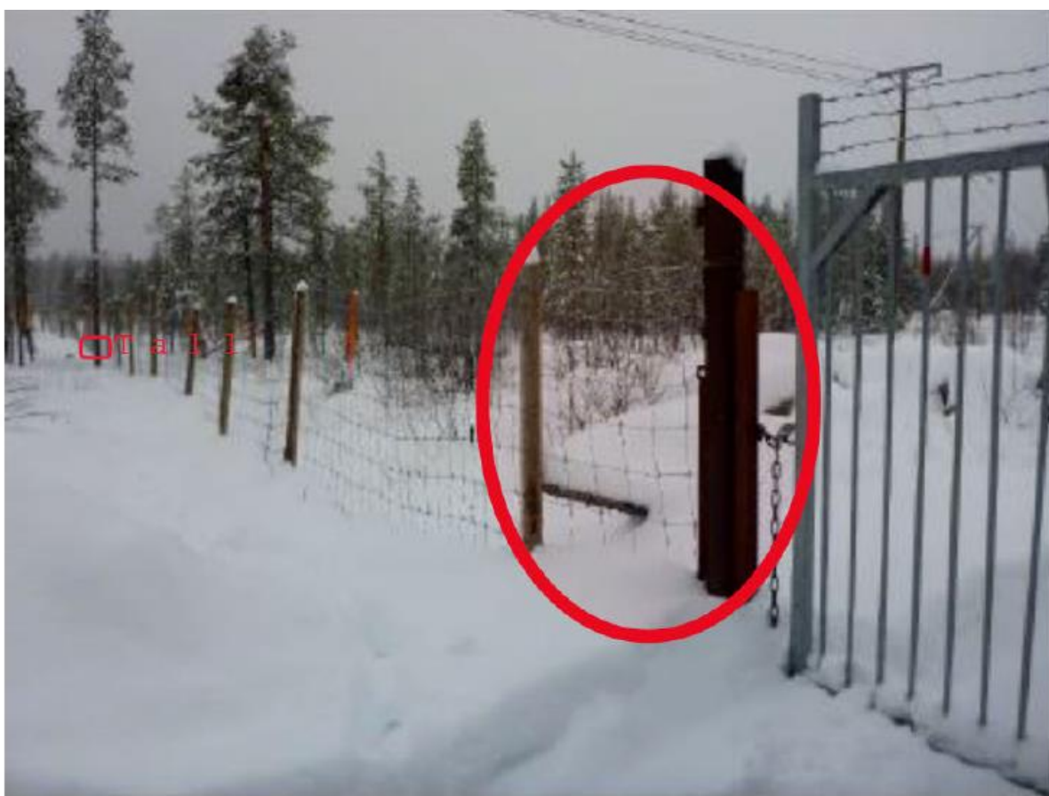
Stängsel i södergående riktning.
