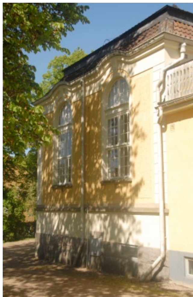
Tingssalen med sina högresta fönster och dekorativa takfot. Foto: David Fuchs 2011.
