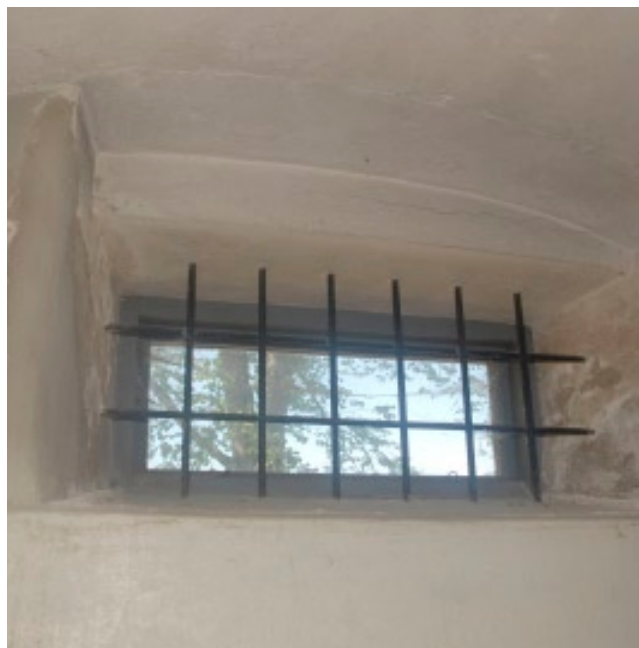
Gallerförsatt fönster i ett av källarens häktesrum.
