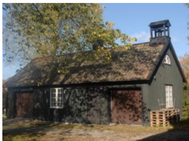
Ekonomibyggnad belägen strax väster om tingshuset. I klocktornet vid östra gaveln hänger den gamla tingsklockan. Foto: David Fuchs 2011.
