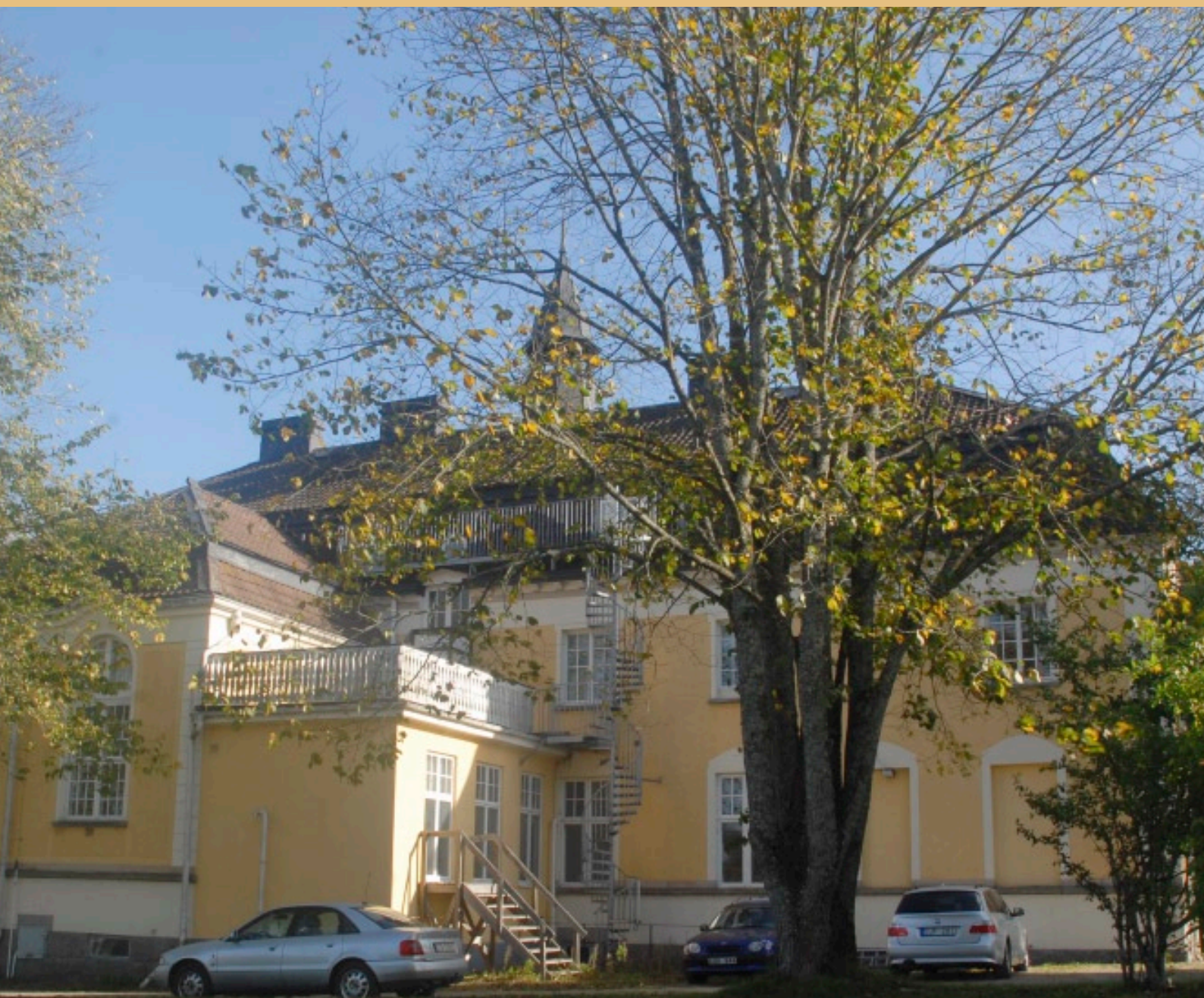
Tingshusets västra fasad sedd från väster. Till höger om tingssalen syns den lägre tillbyggnad, med ovanförliggande balkong, vilken tillkom som överläggningsrum 1948. Foto: David Fuchs 2011.
