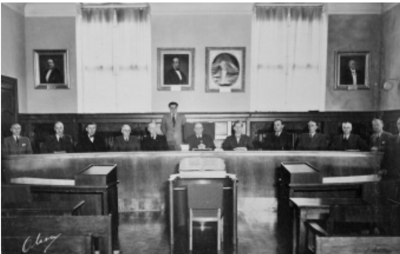
Tingssalens interiör efter ombyggnationen 1948. Rummet har nu fått ett helt nytt stiluttryck i linje med tidens renodlade funktionalistiska stildrag. Emellertid verkar bänkarna i tingssalens nedre del ha bevarats från den gamla interiören emedan övrig inredning bytts ut. Foto: Karl Ekberg.
