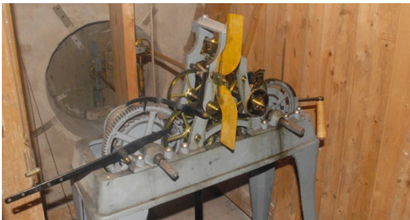
Tingshusklockans urverk placerat på kallvinden på tredje våningen. Foto: David Fuchs 2011.
